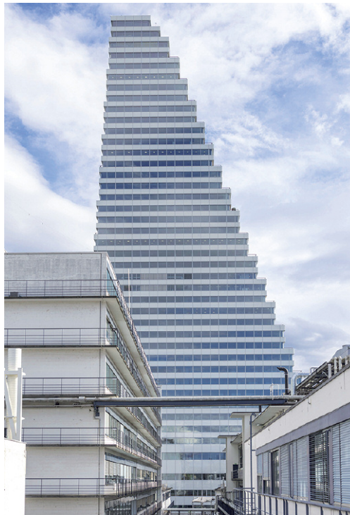
Der soeben fertiggestellte Bau 1 wird Gesellschaft bekommen: Ein zweites Hochhaus im gleichen Charakter wird den zurzeit höchsten Bau der Schweiz noch überragen. Foto Roche Library
