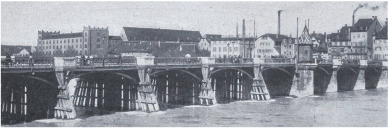
Die alte Mittlere Rheinbrücke mit den charakteristischen Holzpfählern auf der Grossbasler Seite. Aufnahme von 1903, vermutlich das letzte Bild vor dem Abbruch.
