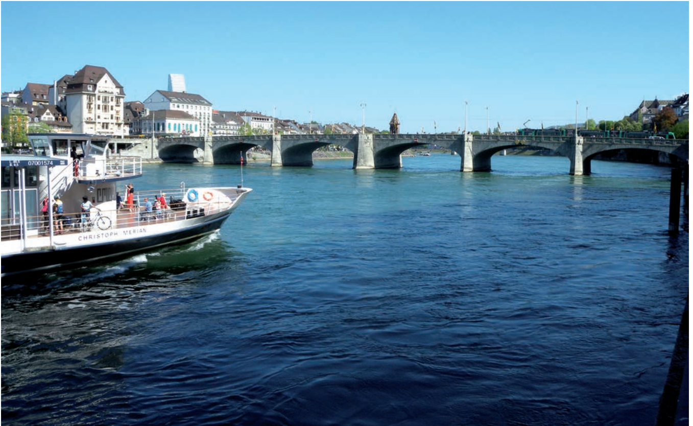
192 Meter lang, erbaut für nahe und ferne Ziele: die Mittlere Rheinbrücke
