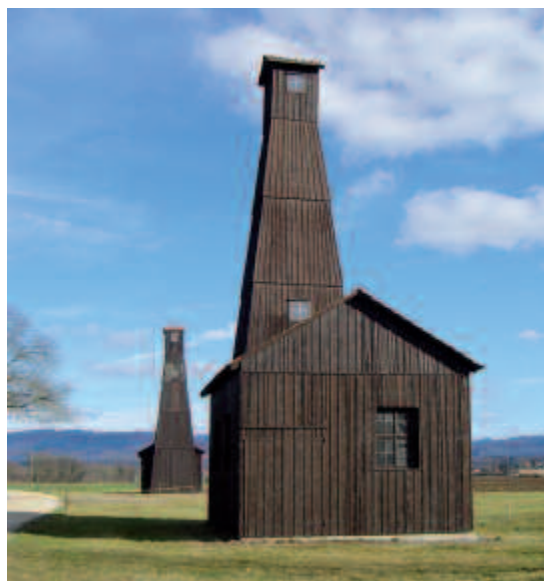
Alte Bohrtürme der Saline Riburg in Rheinfelden
