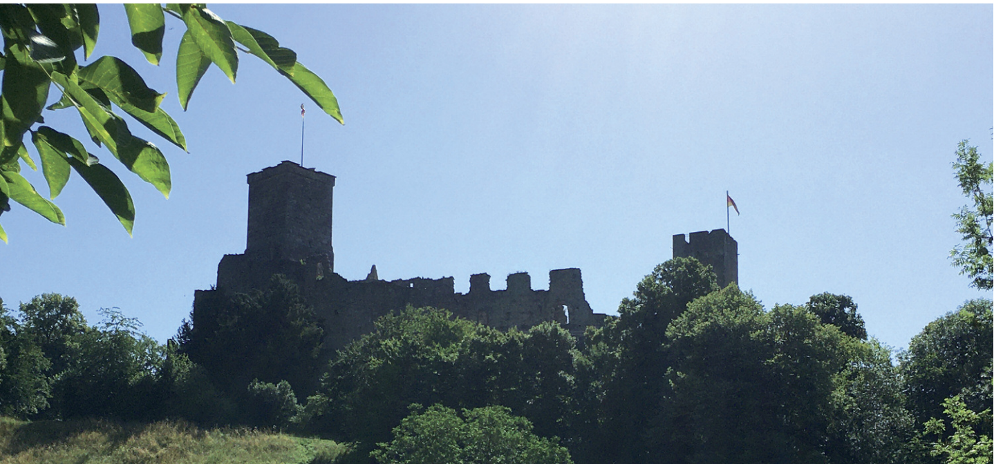
Ansicht der Oberburg von Westen. Links der Bergfried, der zur Längsachse der Burganlage um 45 Grad gedreht erbaut worden ist; Die im Falle einer Belagerung abgefeuerten Geschosse prallen so besser ab. Foto Monika Schenk
