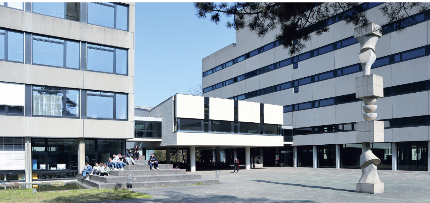
Eingangs- und Pausenhof der Allgemeinen Gewerbeschule. Links der Block E, der die Schulräume der gewerblich-industriellen Berufe beherbergt, rechts der Block G der kunstgewerblichen Berufe, heute Schule für Gestaltung. Verbunden werden die beiden Hauptbauten durch die Aula, einem Kubus auf Stützen. Rechts die Stele von Jean Arp, links die Sitzpyramide von Armin Hofmann. Foto Beat Schenk
